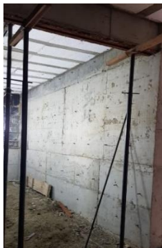
Figura 12 - Parede finalizada-lado interno (vista pelo subsolo)
