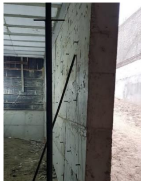
Figura 13 - Parede finalizada - Perfil (vista pelo subsolo)
