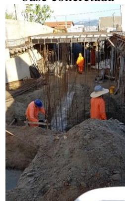
Figura 9: Armadura com base concretada
