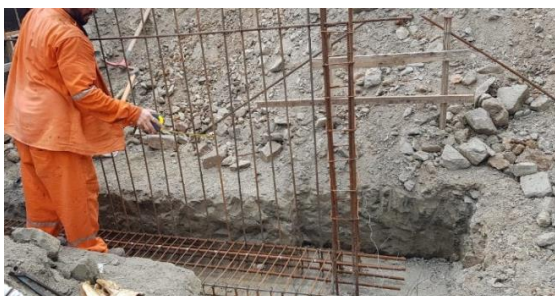
Figura 6: Armadura de base e longitudinais
