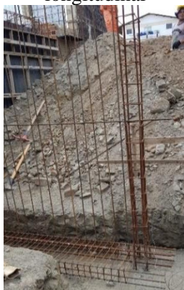
Figura 7: Armadura longitudinal
