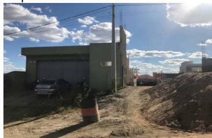
Figura 3 - Edificação do lado esquerdo
