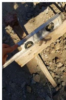
Figura 5: Verificação de nível dos cavaletes
