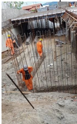
Figura 8: Armadura em toda extensão da parede
