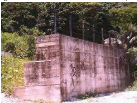
Figura 1 – Muro de Arrimo – Concreto ciclópico
