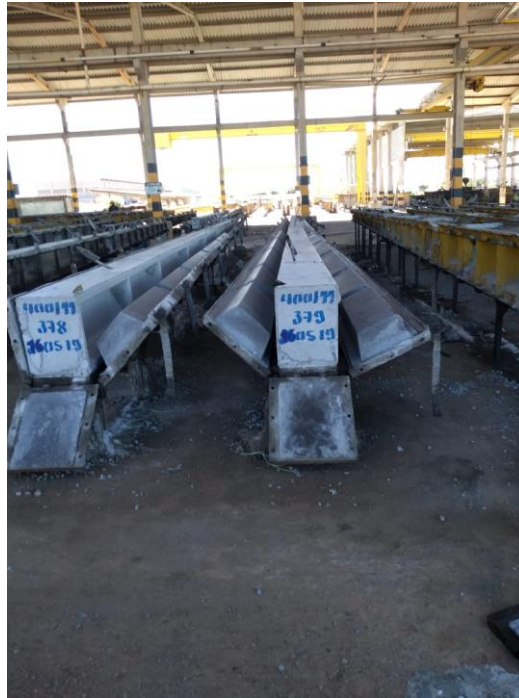
Figura 3 – Formas para fabricação de postes.
