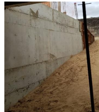
Figura 14 - Parede finalizada-lado externo (vista pelo subsolo)
