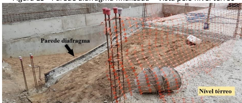
Figura 15 - Parede diafragma finalizada – Vista pelo nível térreo
