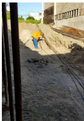
Figura 4: Locação da estrutura
