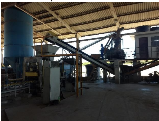
Figura 4 – Esteira depositando os materiais no misturador.
