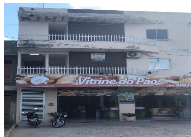
Figura 4 - Edificação do lado direito
