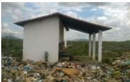
Figura 3 - Galpão de armazenamento dos pneus inservíveis da Prefeitura
