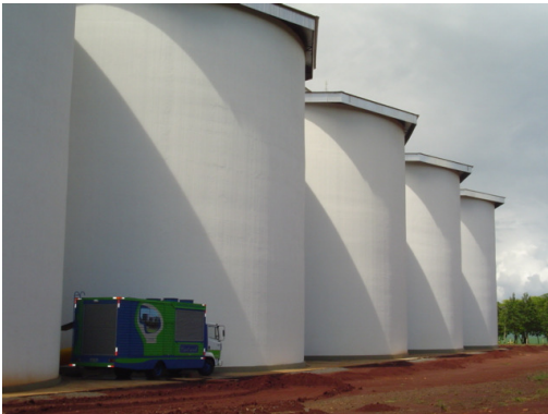
Figura 1. Vista dos silos de concreto utilizados no experimento e do equipamento de refrigeração artificial.
