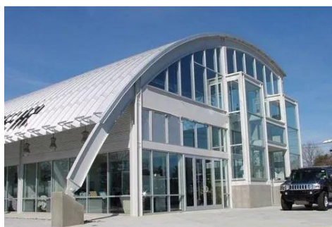
Figura 1 – Exemplo de arco em perfil I ( https://produto.mercadolivre.com.br/MLB-813319665-estrutura-metalica-galpo-cobertura-metalica-mezanino-JM )
