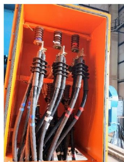
Figura 2.3: Caixa terminal do gerador.
