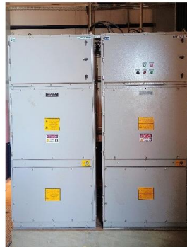
Figura 2.21: Cubículo de surto e fechamento de neutro (Fornecimento WEG).
