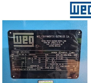
Figura 2.2: Placa de dados do gerador.
