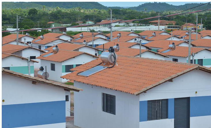
Figura 1 - Casas com aquecimento solar de água no Estado do Piauí. Fonte: [21]
