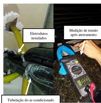
FIGURA 5. Eletrodutos instalados e testagem da carcaça Fonte: Autoria própria, 2021.
