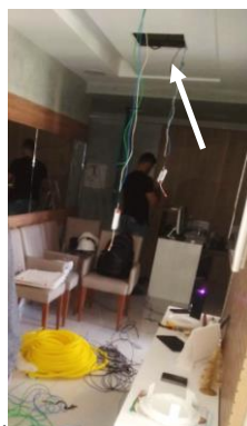
FIGURA 7. Processo de aterramento das luminárias Fonte: Autoria própria, 2021.
